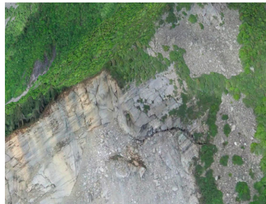
(b) 航拍三维模型影像
