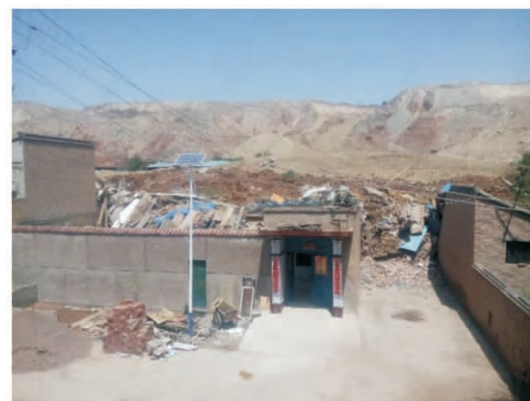
图 14 滑坡体前方的房屋
