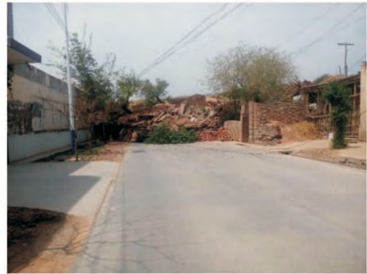
图 13 堆积体堵塞道路
