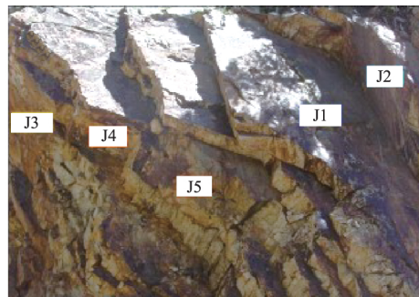
图 7 结构面现场照片
