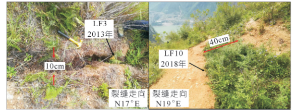
图 2 典型裂缝 Fig. 2 Typical cracks
