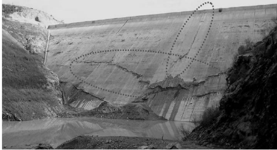
图 1 Canoas Novos 混凝土面板堆石坝
