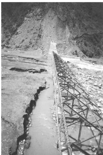
图 5 四川西昌东河泥石流柔性防护工程
